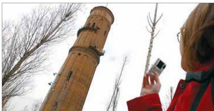
La Torre de les Aigües és obra de l'arquitecte Pere Falques, es va inaugurar el 1882 i té 63 metres d'alçada ■ ROBERT RAMOS
